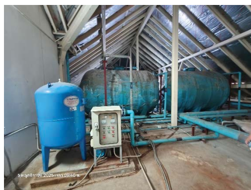
ถังเก็บน้ำขึ้นหลังคา
